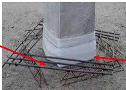
Folha de poliestireno de 10 mm de espessura em torno do perímetro
