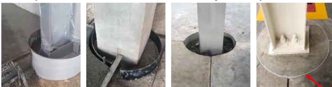
Colocar a junta tipo correia, despejar por fora, assim que começar a endurecer (3 a 6 horas após o derramamento), colocar poliestireno e preencher por dentro.
