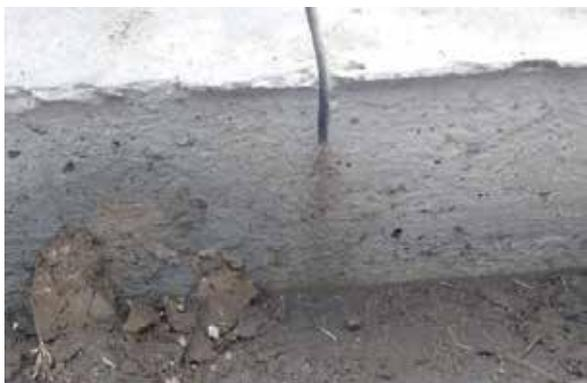
*Pode-se observar que em um piso com o aditivo FIBRATEC-CR, não há fissura apesar da zona enfraquecida com o corte. (detalhe tecnico mesmo com o aditivo compensador o corte serve para induzir a fissura ate a base do piso)*
